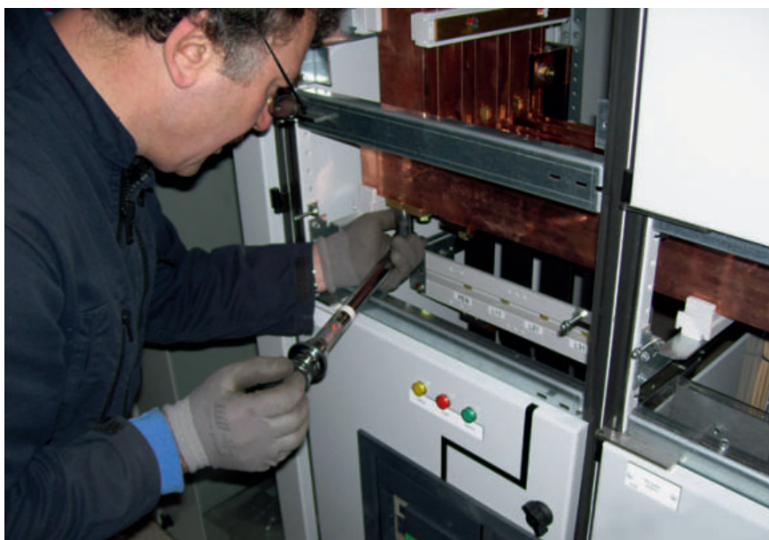
Assemblage mécanique d'un tableau
